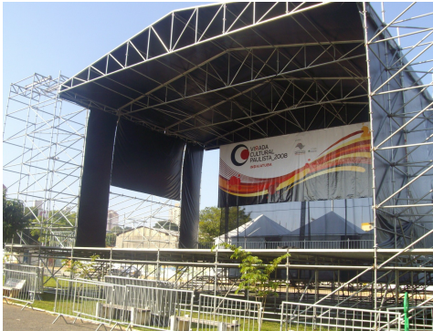
Figura 1 - Montagem de palco (Indaiatuba, 2008)
