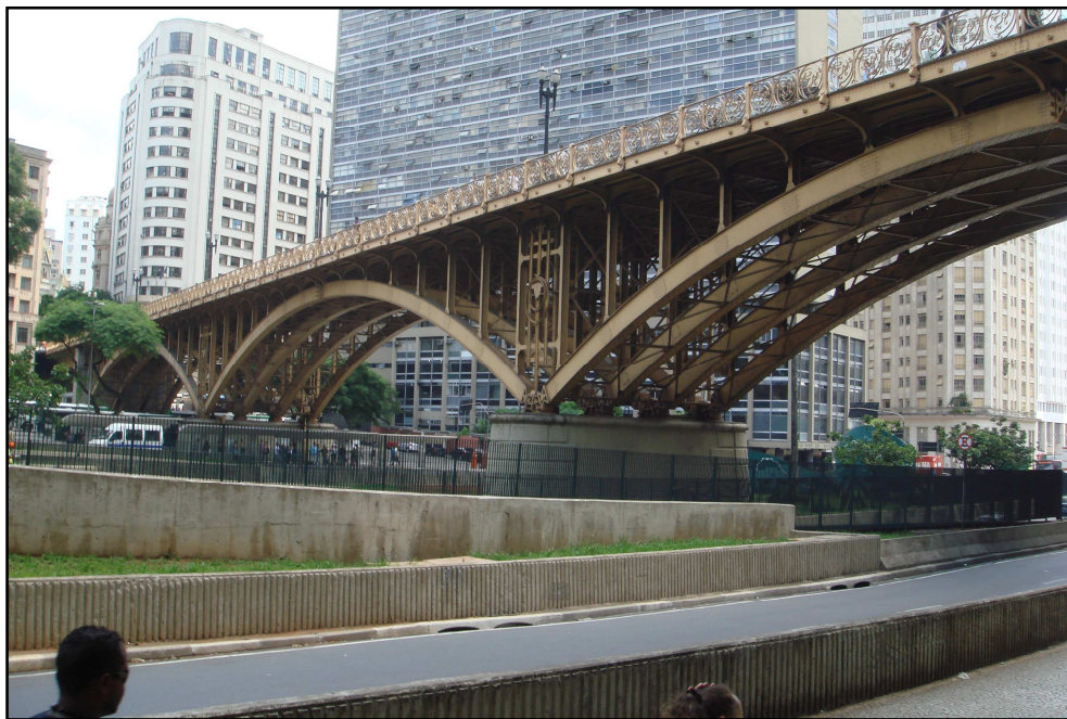
Figura 4: Viaduto Santa Ifigênia
