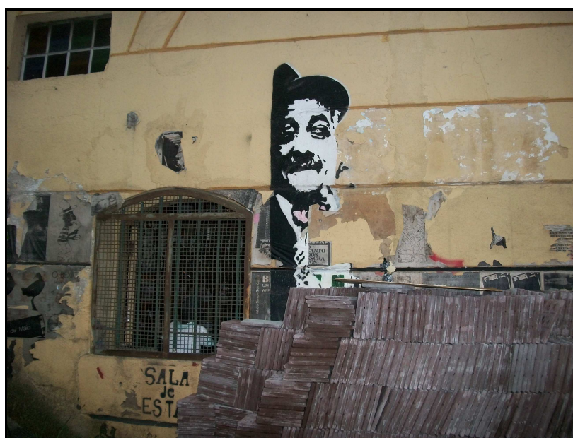
Figura 9: O local se transformou em depósito de material de construção.
