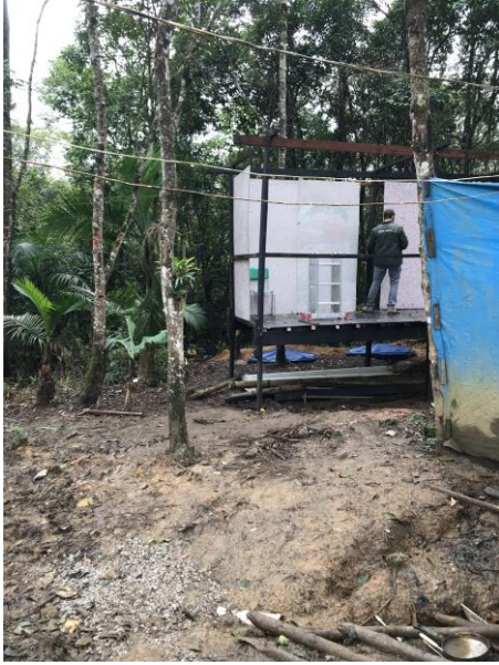
Foto 5 – Banheiros secos sendo instalados (2 de agosto de 2018)
