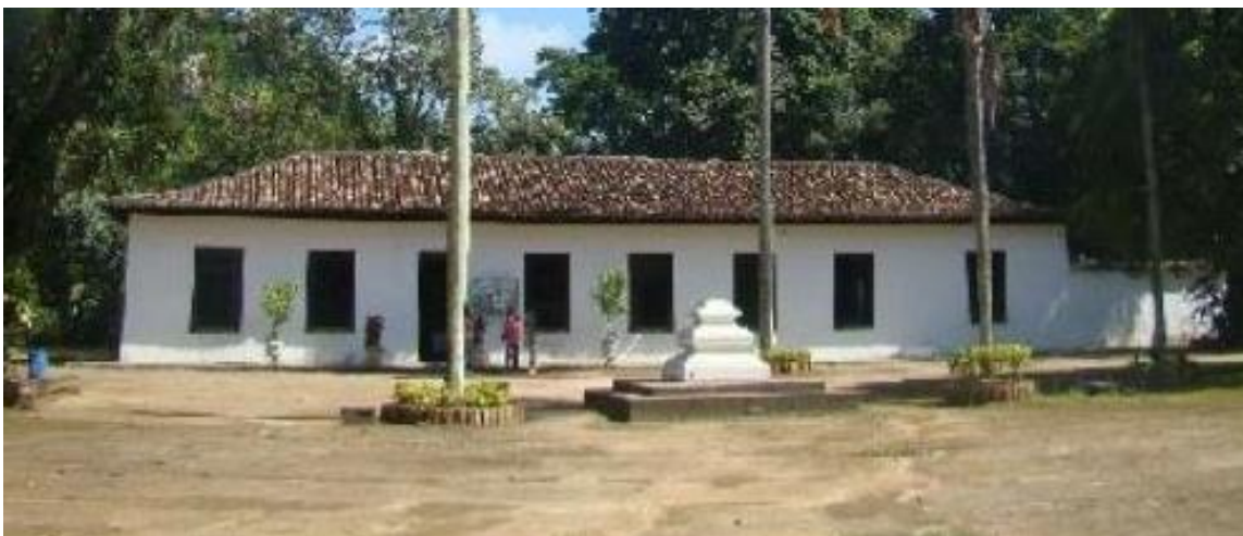
Figura 27 – Na Área montada em Taubaté no Museu Folclórico Pedagógico Monteiro Lobato, uma casa térrea totalmente compartimentada
